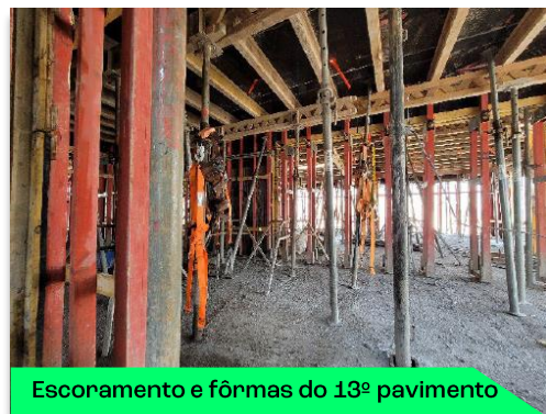
Pré-concretagem do 14º pavimento
