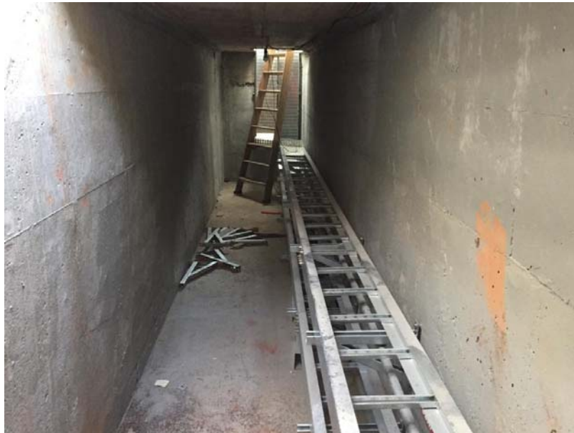
Instalação do leito para passagem dos alimentadores – Galeria Subterrânea
