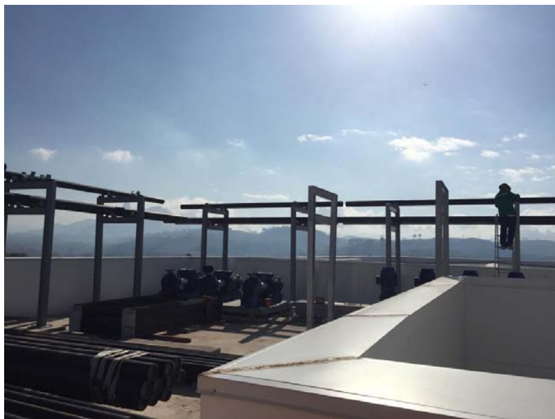
Montagem da Central de Água Gelada (CAG) do ar condicionado.
