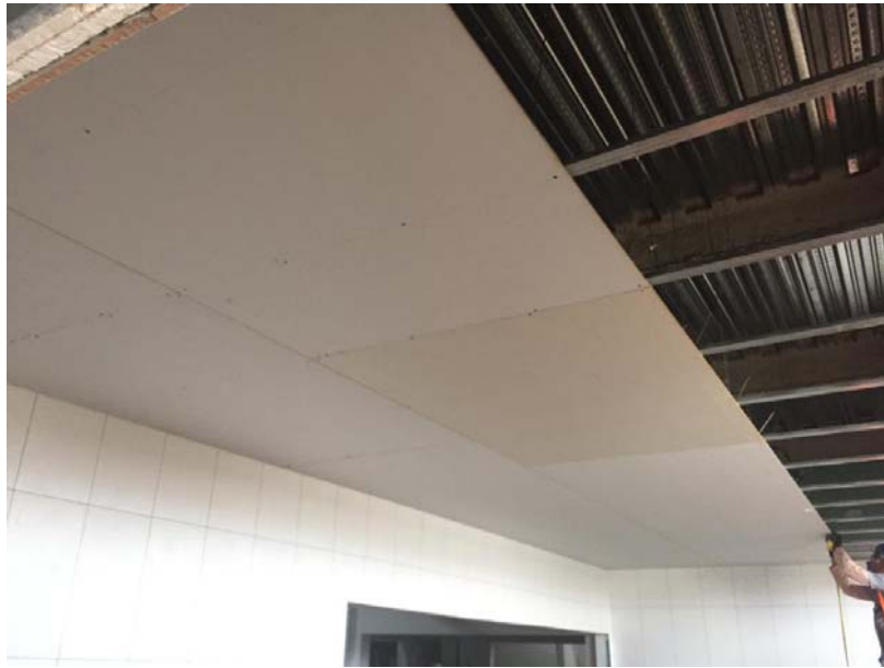
Fechamento de forro. (CME, UTI e Centro Cirúrgico).
