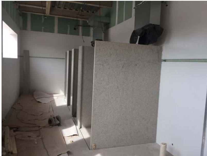
Instalação das divisórias em granito nos vestiários do Centro Cirúrgico.
