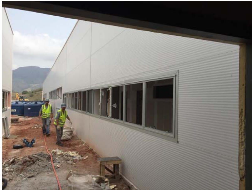
Instalação das esquadrias. (Centro Cirúrgico, Diagnostico e Área Técnica 1ºPav.)
