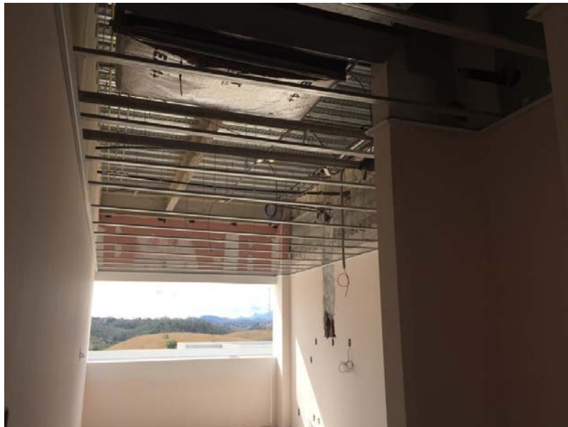
Início da estruturação do forro nas internações.
