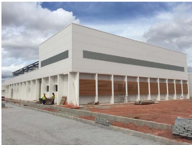
Instalação das esquadrias e termobrise no Centro Cirúrgico.
