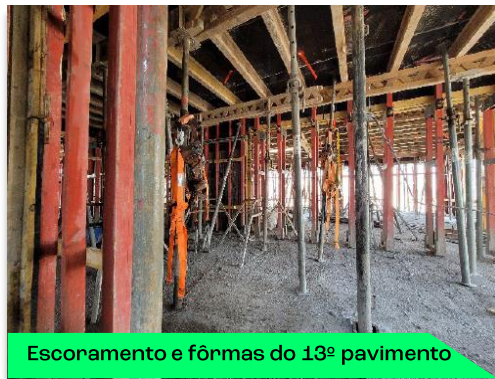
Pré-concretagem do 14º pavimento
